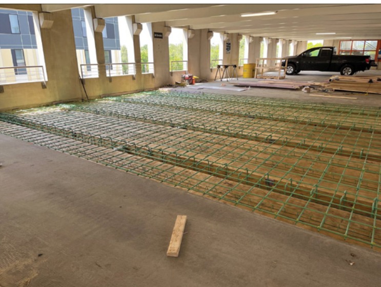
Image 10: Reinforcement for monolithic pour
