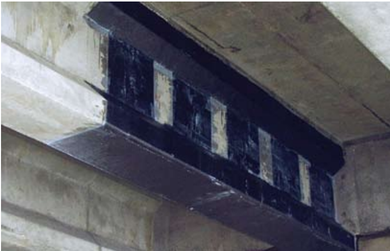
CFRP layout on AASHTO girders
