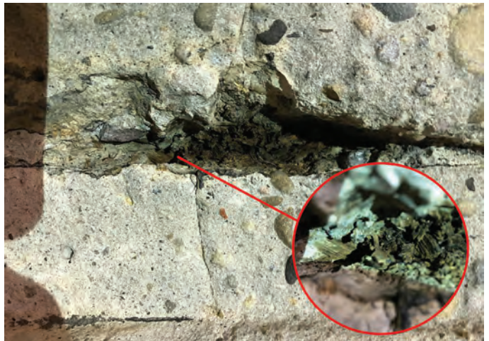
Fig. 2: Wood debris embedded at pour joint interface
